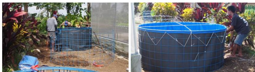
**Gambar 4.** Pemasangan Kolam Terpal
