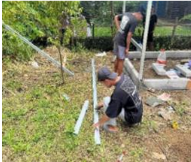
Gambar 3. Pemasangan rangka kandang
