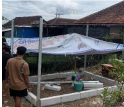
Gambar 2. Persiapan lokasi pembangunan
