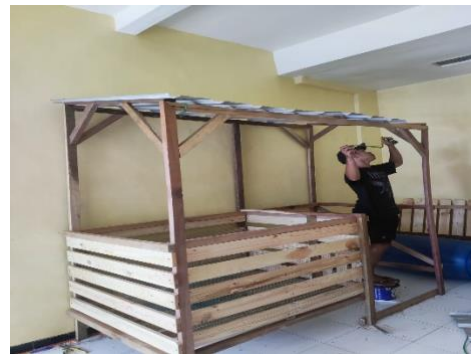
Gambar 4. Pembuatan tempat kompos kering
