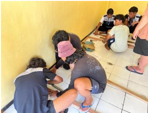
Gambar 3. Pembuatan Kotak Kayu
