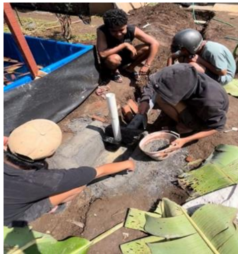
Gambar 5. Pembuatan Saluran Pembuangan
