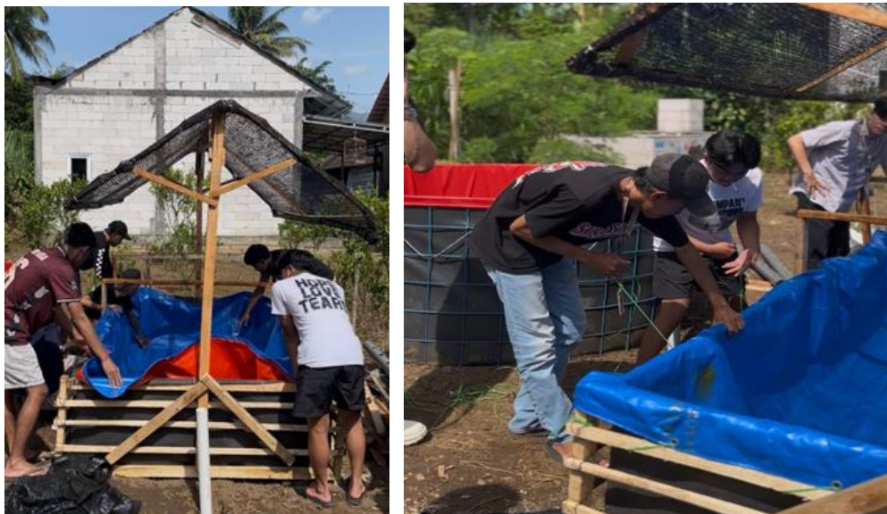
Gambar 4. Pembangunan Kolam Lele
