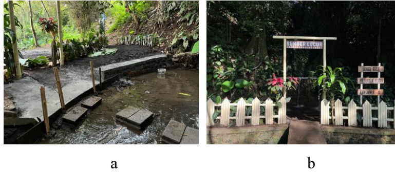
Gambar 1. Pembuatan pagar pembatas (a) dan pagar pelindung (b)
