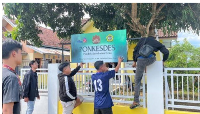
Gambar 3. Proses Pemasangan Neon Box
