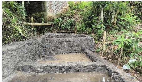
Gambar 10. Kondisi Sumber Mata Air sesudah Pembangunan Belik
