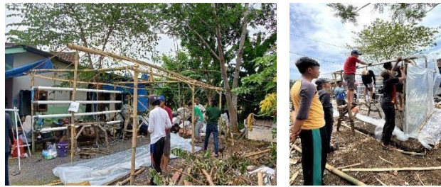
Gambar 6. Pemasangan plastik UV micron
