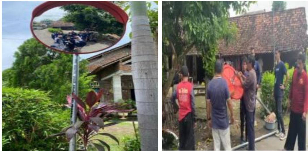
Gambar 4. Pemasangan kaca cembung di perempatan jalan Dusun Jomblang
