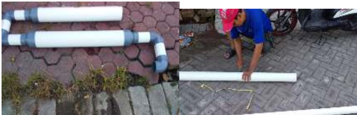
Gambar 5. Proses Pemasangan alat
