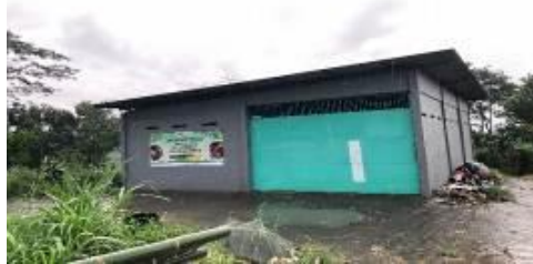
Gambar 2. Tempat Pembuangan Sampah Terpadu (TPST)
