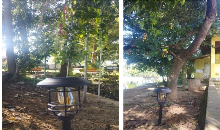
Gambar 9. Pemasangan lampu taman tenaga surya estetik
