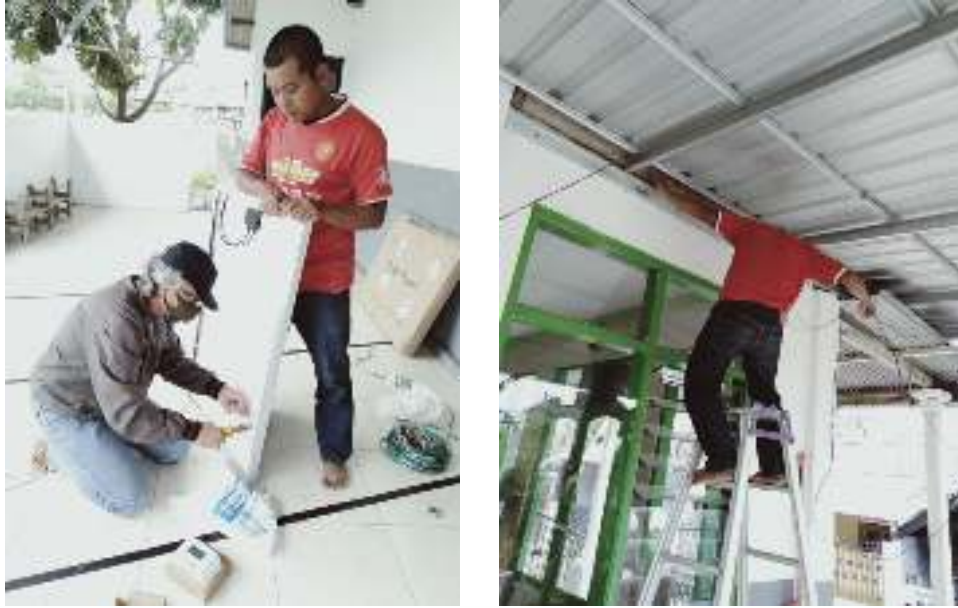
Pemasangan Panel Surya
