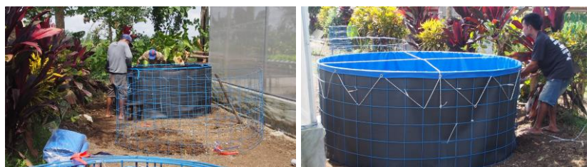
Gambar 4. Pemasangan Kolam Terpal
