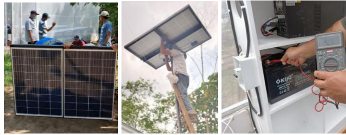
Gambar 5. Pemasangan PLTS
