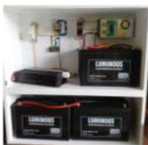
Gambar 4. Pemasangan Box berisi Baterai, Solar Controller dan Inverter
