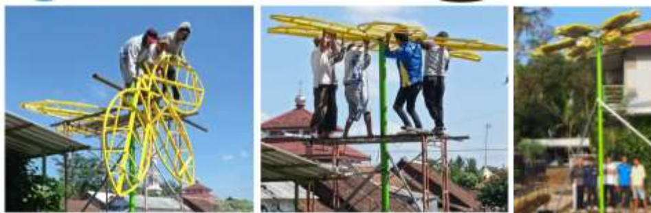
Gambar 3. Pemasangan Bracket Panel Surya
