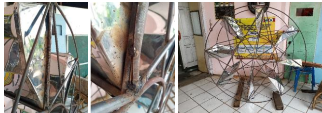
Gambar 10. Tahapan pemasangan sudu ( blade )
