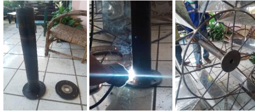
Gambar 11. Pemasangan inner flange – bushing pada frame kincir air
