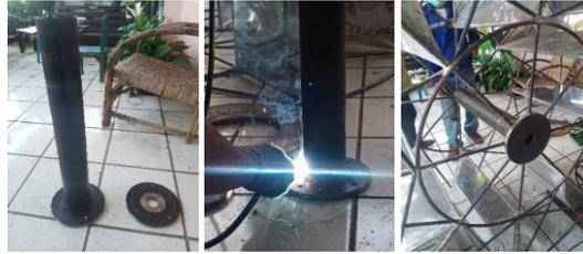
**Gambar 11.** Pemasangan *inner flange – bushing* pada *frame* kincir air
